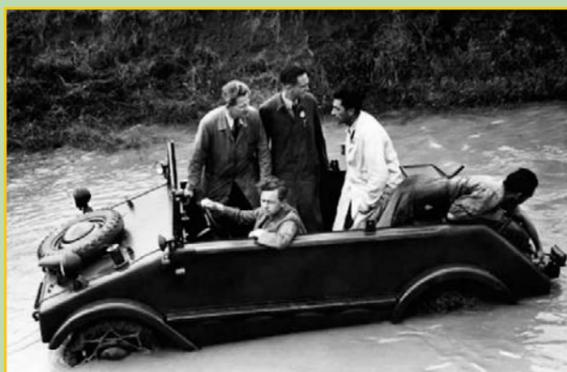
La prima versione della VW anfibia, la Typ 128 adottava il pianale della Typ 82, con passo di 2,4 metri, e una carrozzeria poco indovinata.
