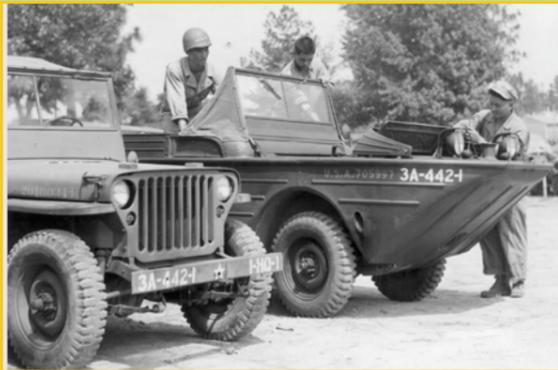
La versione anfibia della Jeep faceva parte della gamma di veicoli necessari per i futuri teatri operativi previsti per l'US Army. Dimensioni e agilità della GPA erano diverse dalla MB/GPW, il peso era superiore ma il motore e la meccanica dei due veicoli erano gli stessi.
