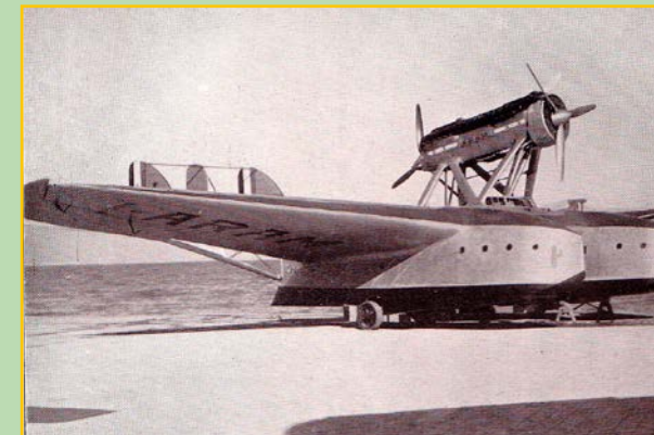
I due motori Isotta Fraschini Asso 750 che equipaggiavano gli S55 X erano dei 18 cilindri a W con cilindrata di 47,07 litri, con potenza di 930 CV a 1.900 giri.
